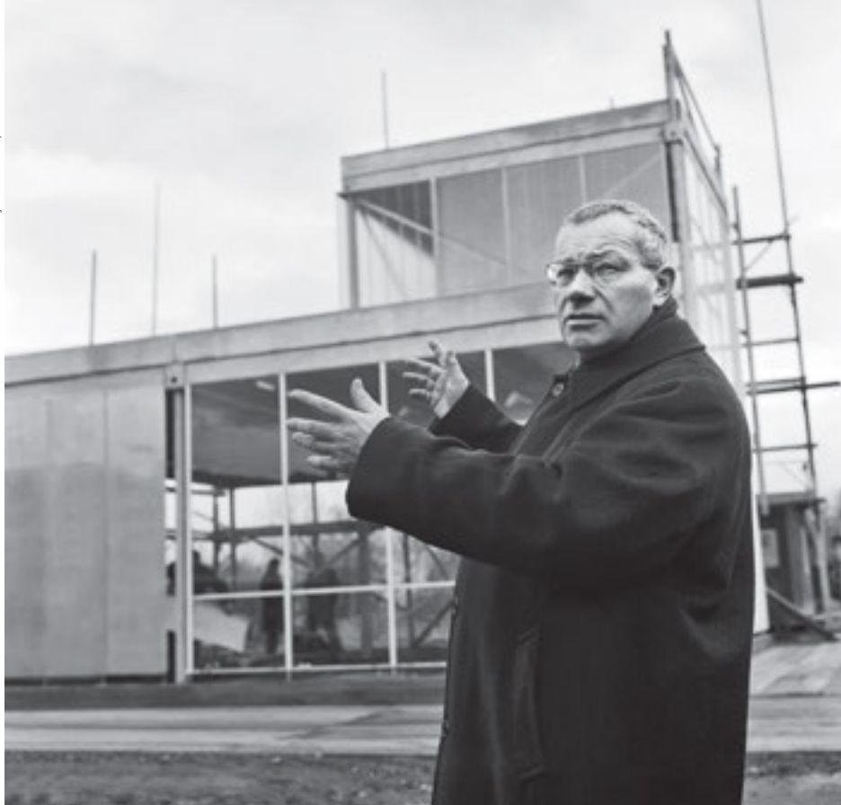
L'artiste Max Bill, architecte de la section «Eduquer et créer» de l'Expo 64, sur son chantier
