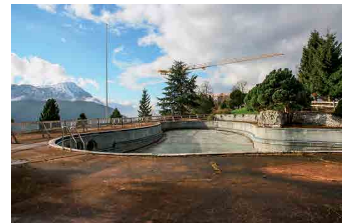
Das Bürgenstock-Freibad mit den drei Unterwasserfenstern (2014/15)
